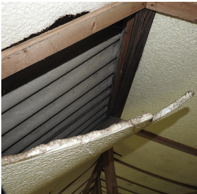
Loshangende dakisolatie (in schuur A)
