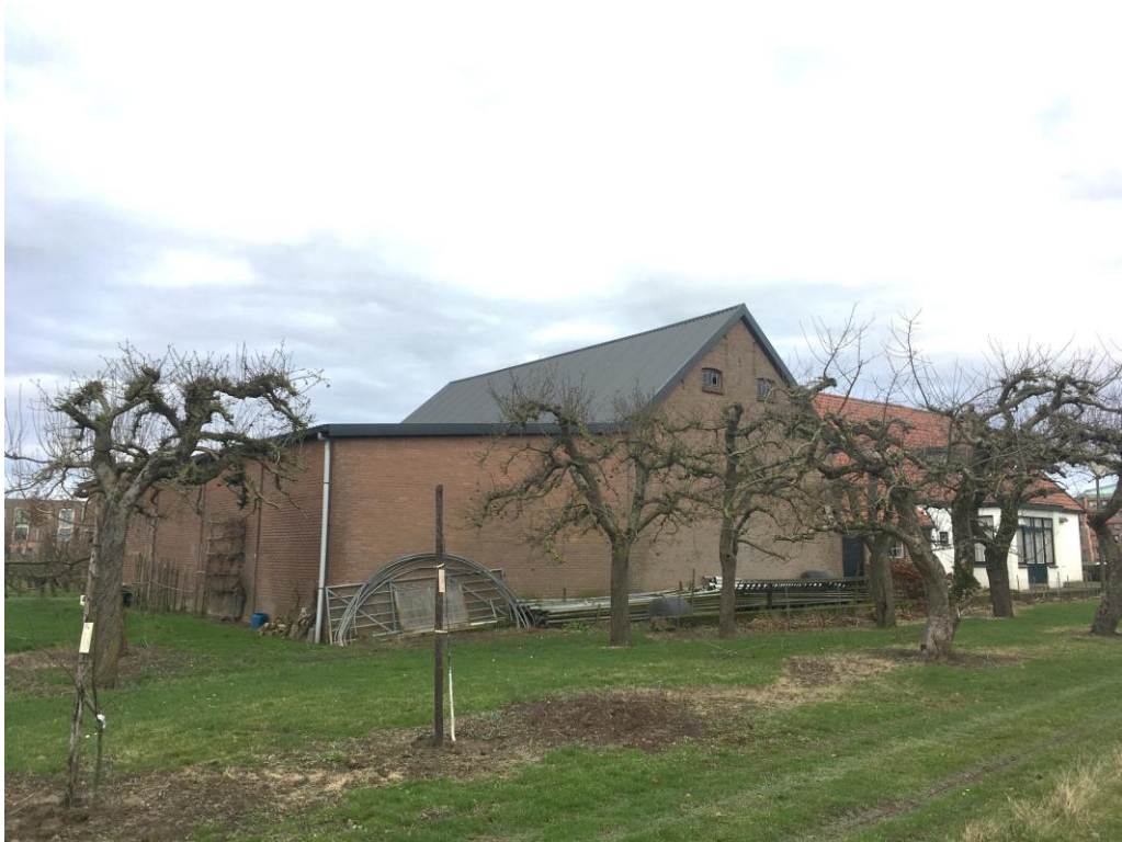
Figuur 4 De tweede te slopen schuur betreft een voormalige fruitopslag welke grenst aan het te behouden woonhuis. Deze schuur is opgetrokken uit gemetselde muren en draagt een prefab geïsoleerd golfplaten dak.
