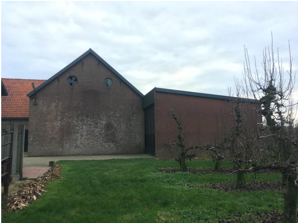
Figuur 3 De te slopen schuren betreffen een vrijstaande schuur is opgetrokken uit gemetselde muren en draagt een prefab geïsoleerd golfplaten dak.
