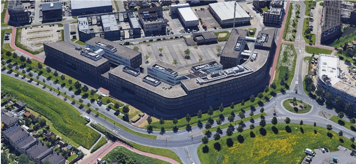
Afbeeldingen 2 & 3: luchtfoto's van weerszijden van het gebouw
